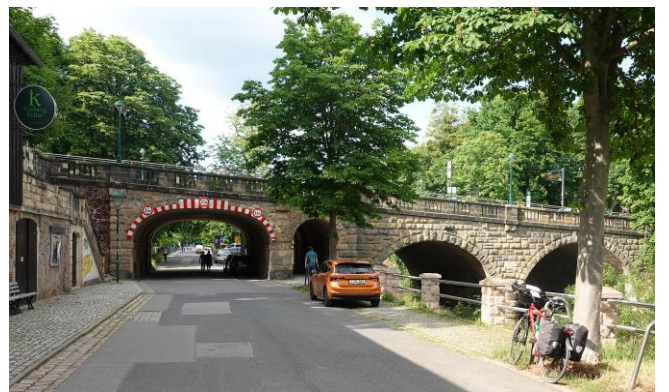
Die Kaßberg-Auffahrt in Chemnitz
