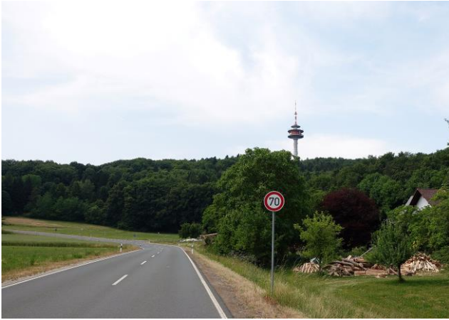
Fernmeldeturm Riegelstein, letzter Aufstieg vor der Schermshöhe
