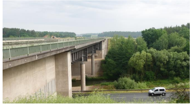
M-D-Kanalbrücke über die Schwarzach
