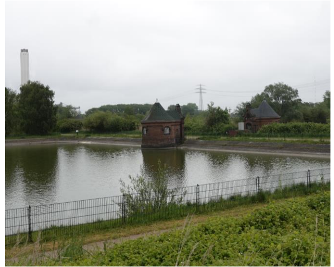
Wasserkunst Kaltehofe – Industriedenkmal Trinkwasser Filtrationswerk für Hamburg
