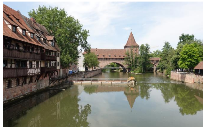
Schlayerturm in Nürnberg
