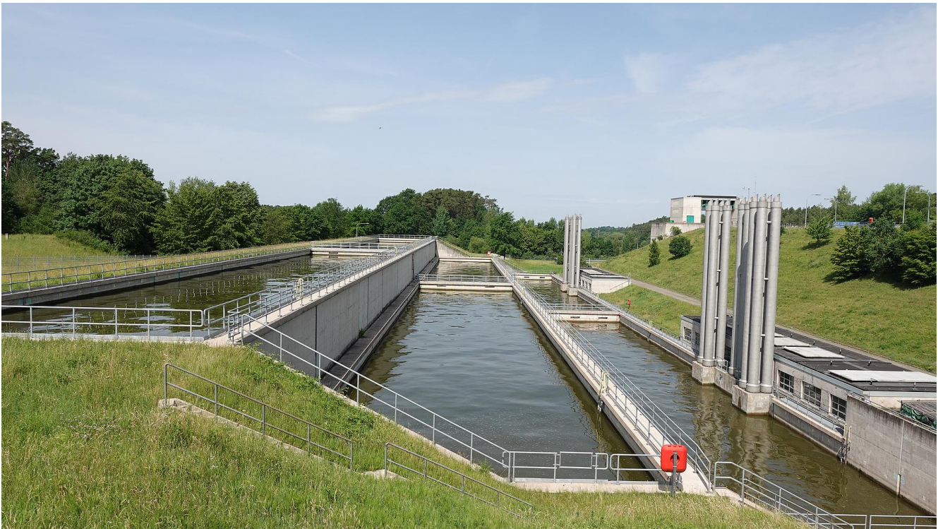
Die Rückhaltebecken einer Sparschleuse, hier bei der Schleuse Hilpoltstein am Main-Donau-Kanal.
