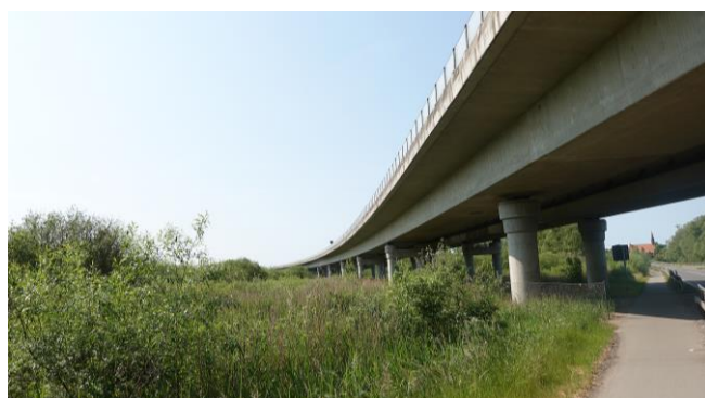
Peenetalbrücke bei Jarmen, sie überquert das Naturschutzgebiet
