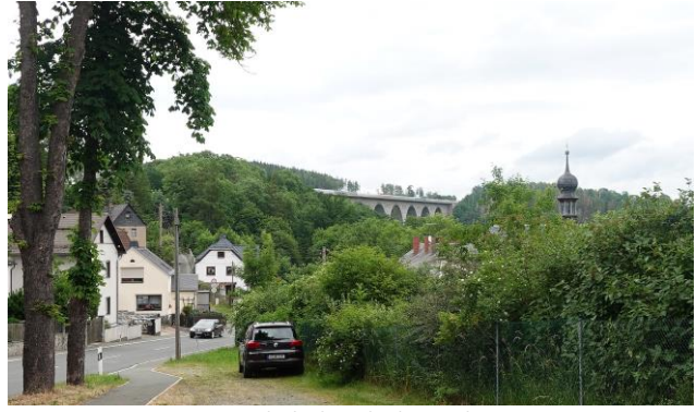
Autobahnbrücke bei Pirk
