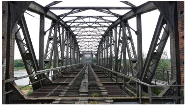
Brücke der «Kanonenbahn» bei Barby
